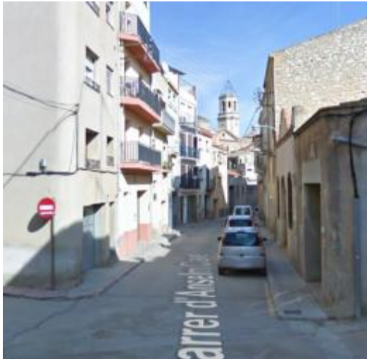
Arranjament carrer Anselm Clavé L'Espluga de Francolí Inici obres
