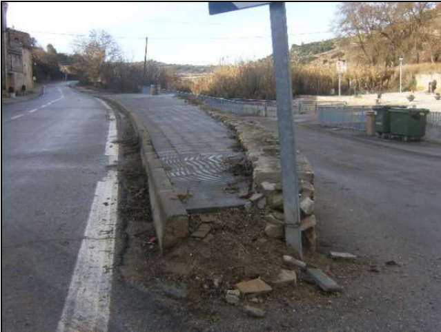
Inici de la rehabilitació
