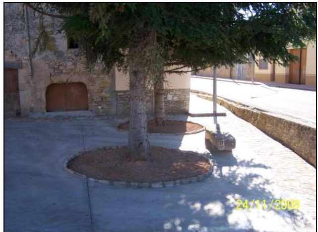
Estat actual de la rehabilitació
