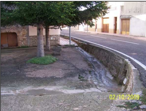
Inici de la rehabilitació
