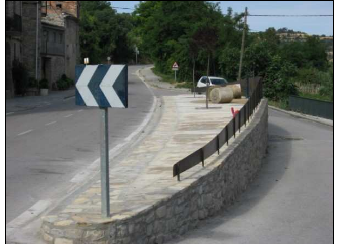
Estat actual de la rehabilitació
