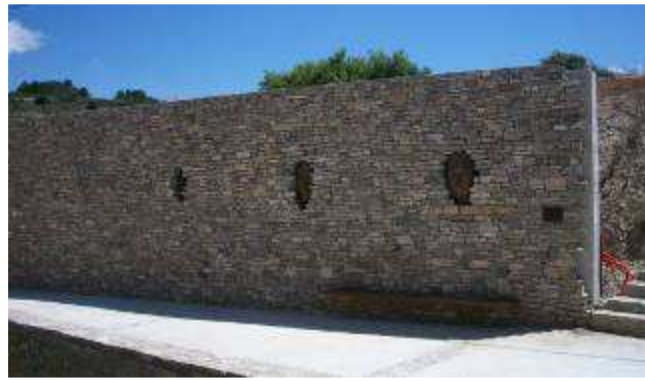
Estat final de la rehabilitació
