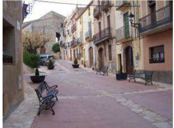
Estat final de la rehabilitació
