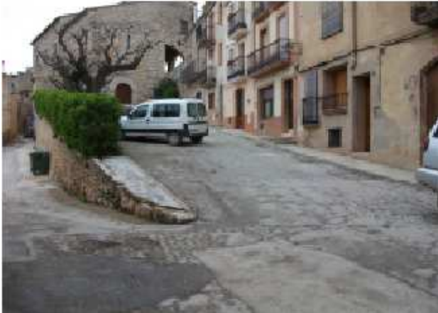
Urbanització c/ Promasó (Barberà de la Conca) Inici rehabilitació
