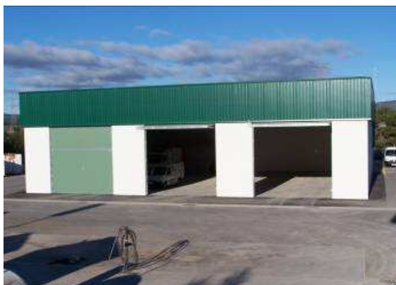
Ampliació nau servei de recollida
