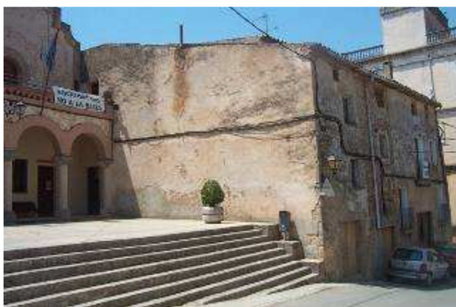
Construcció edifici c/St. Antoni, 29 (Rocafort de Queralt)
