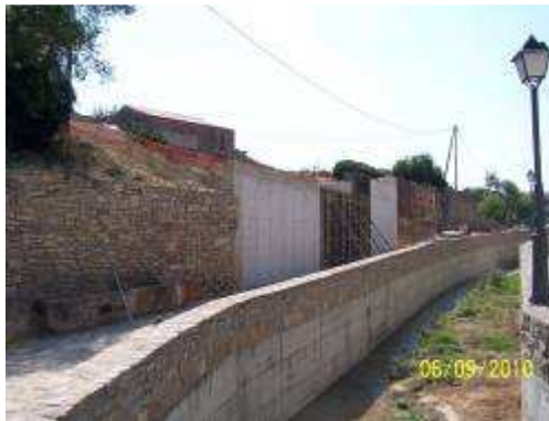
Revestiment mur del riu (Conesa) Inici rehabilitació
