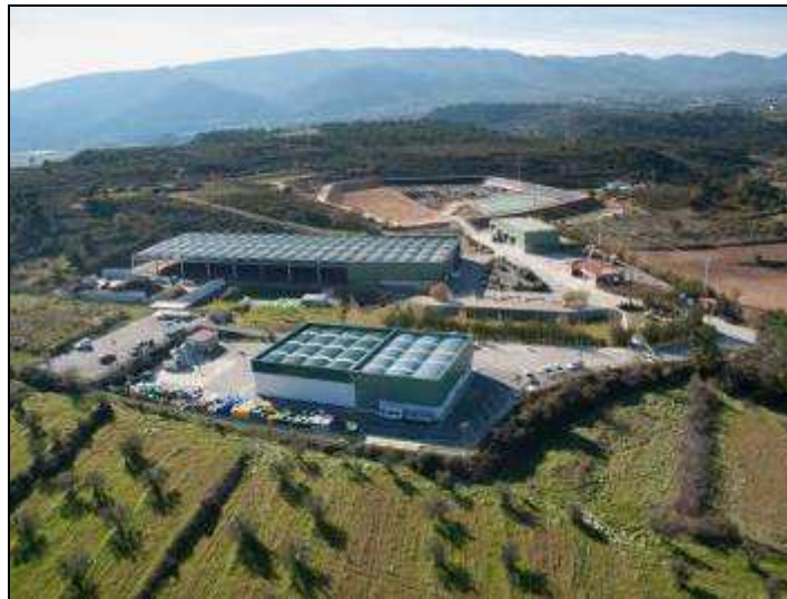
Centre Comarcal de Tractament de Residus. Vista aèria
