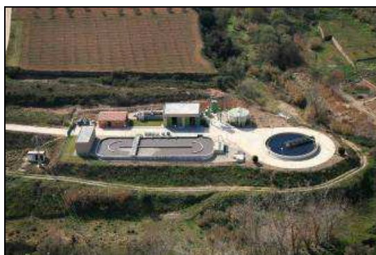
EDAR Sta. Coloma de Queralt
